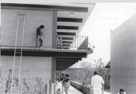
Construcción del Plantel Sur 1972
