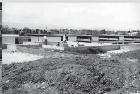
Construcción edificios Plantel Vallejo 1971
